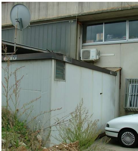
Foto n° 19: veduta del locale magazzino nel monoblocco prefabbricato addossata alla facciata nord
