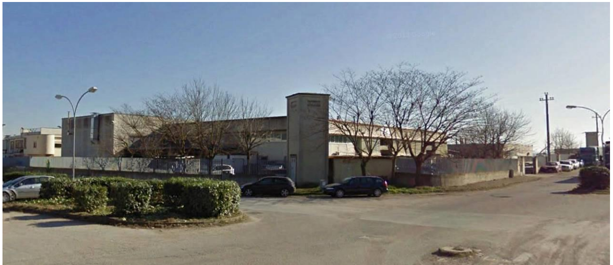
Foto n° 2: veduta da via delle Industrie
