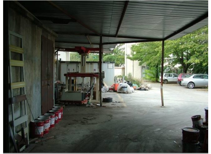
Foto n° 16: veduta interna alla tettoia addossata alla facciata nord
